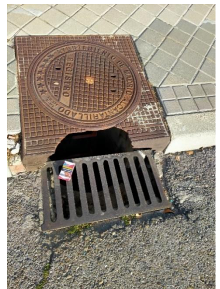
Alcantarilla en Niceto Alcalá Zamora, frente al bulevar.
